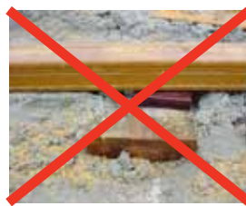
Die Unterkonstruktion nicht verschrauben
