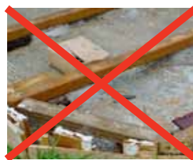
Lassen Sie 10mm Fugen zwischen den Lagerhölzern
